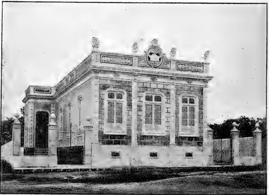
44. — Edifice scolaire, à Manáos.
